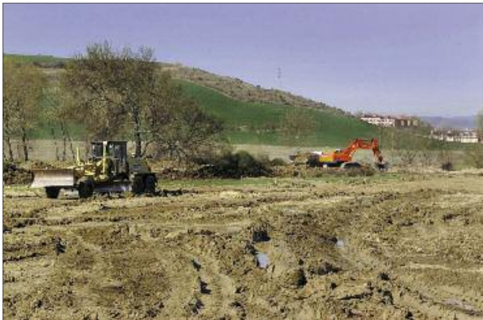
Primeros trabajos de las obras de urbanización.
