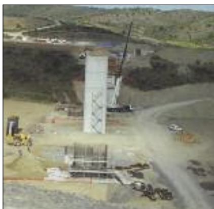
Tramo 1. Acueducto Gurpegui.
