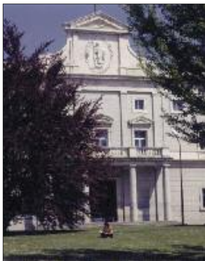
Exterior del edificio central de la Universidad de Navarra.
