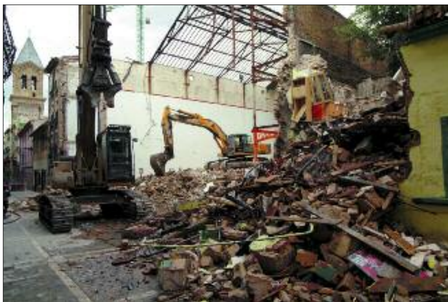
Derribo del histórico frontón Euskal Jai.
