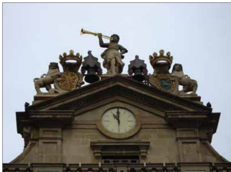
Ático de la fachada del Ayuntamiento de Pamplona.
